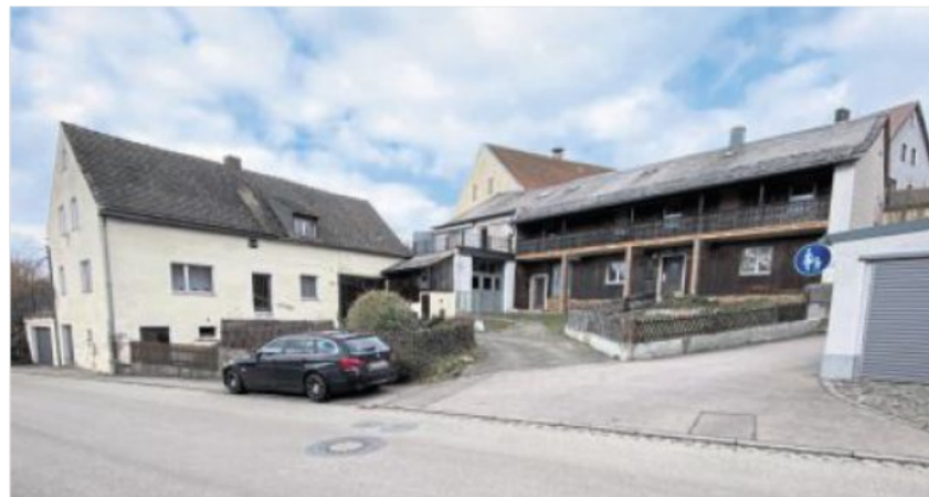
An der Tiefen Gasse in Tannesberg sollen zwei Häuser abgerissen werden. Es ist eine ortsgestalterische Maßnahme bei der Dorfsanierung.
